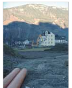
Durch die Kanalverlegung in der Gerberstraße kann Getzner den Betrieb erweitern.
