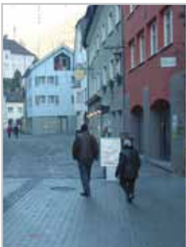
In der Rathausgasse wurden die Oberflächen verbessert.
